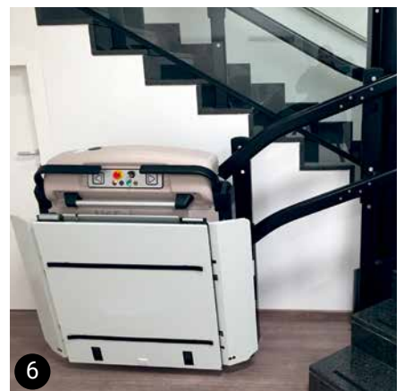
1 Cabine EVP 2 Monte-escalier droite 3 Monte-escalier courbe 4 Plate-formme élévatrice oblique (SER) 5 Plate-forme élévatrice vertical (HDP) 6 Plate-forme élévatrice pour handicaps (SPV)
