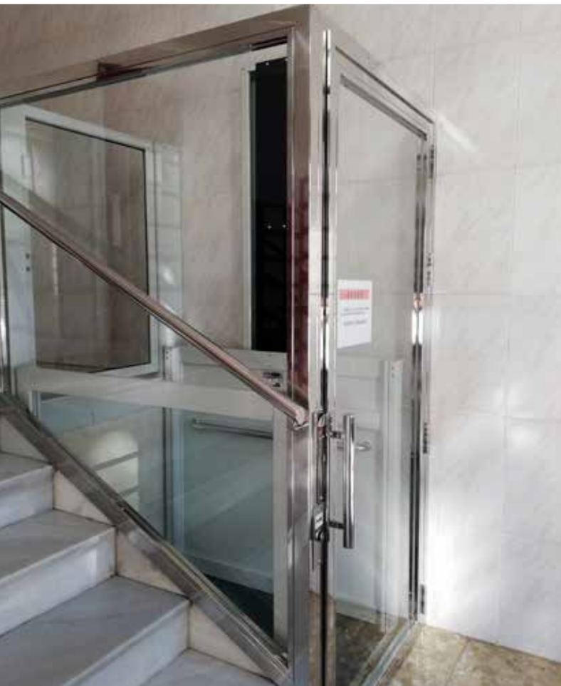
Cerramiento hueco en acero inox. y cristal por cuenta del cliente.
